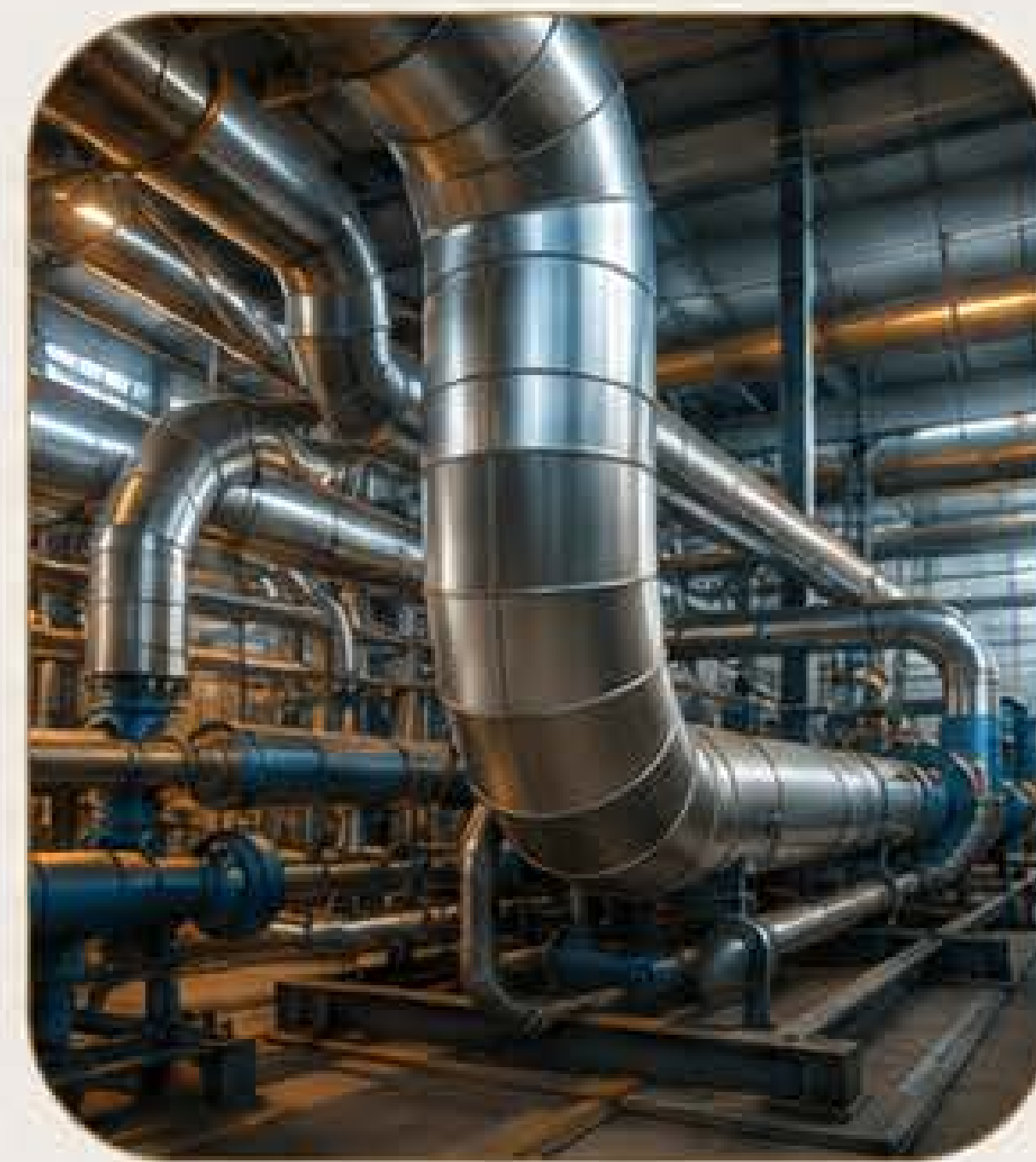
الأعمال الكهروميكانيكية Electromechanical Works
