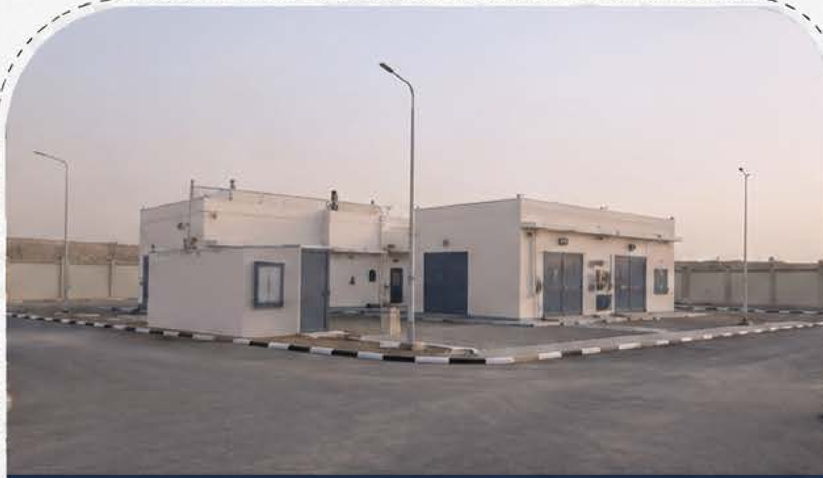
الواجهة الرئيسية للمحطة
